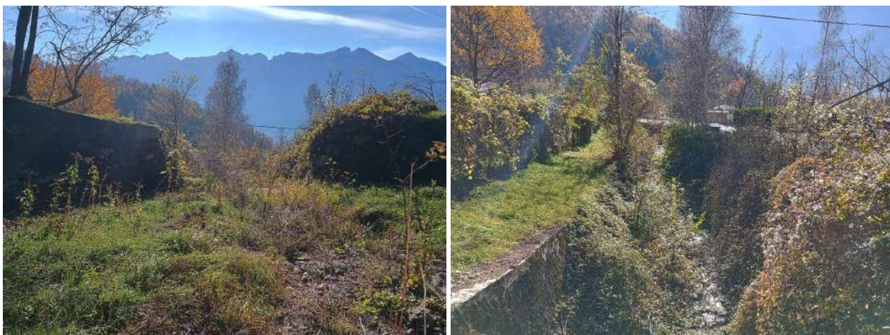
Fig. 1.41 -1.42 – Briglia a fessura a chiusura della piazza di deposito e inizio cunettone.
