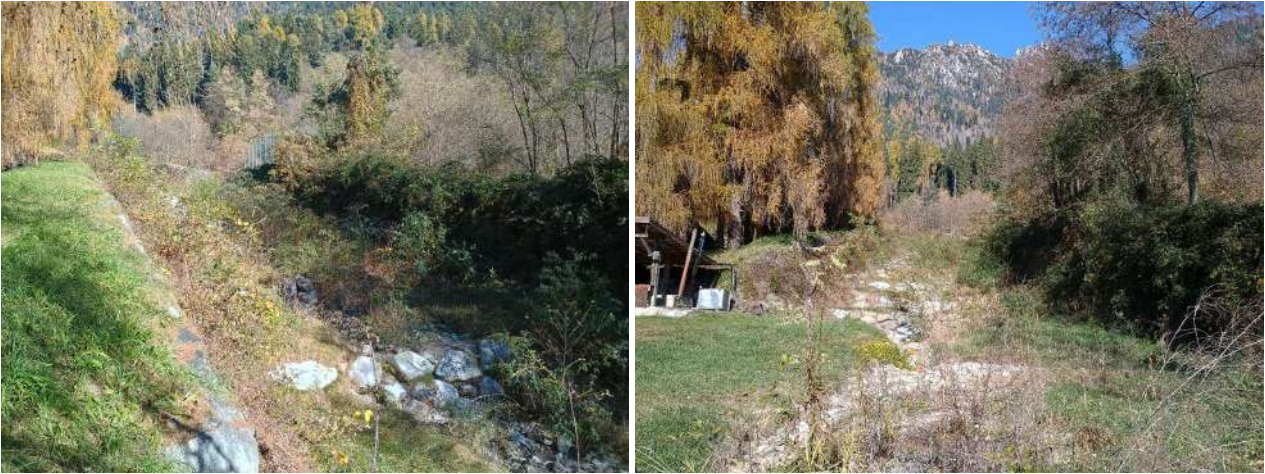
Fig. 1.31 – 1.32– tratto in corrispondenza dell'area ricreativa. Si possono osservare gli imponenti argini alterali e il consolidamento del fondo con una serie di opere in massi.
