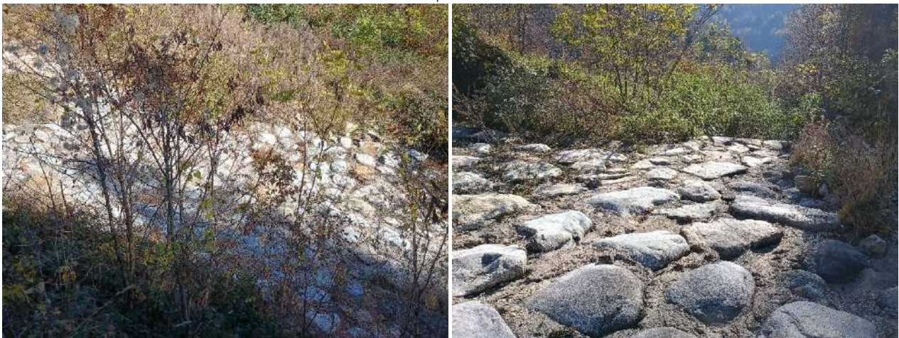
Fig. 1.33-1.34 – Tratto con selciatoone i massi e cls a monte del secondo guado
