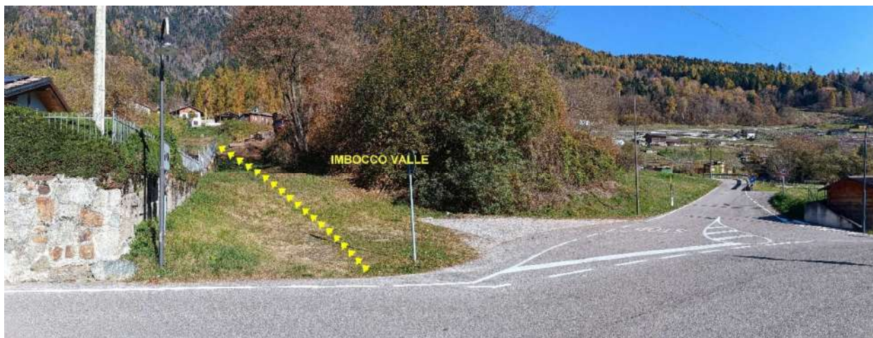
Fig. 1.7 – Imbocco di valle della nuova bretella in progetto
