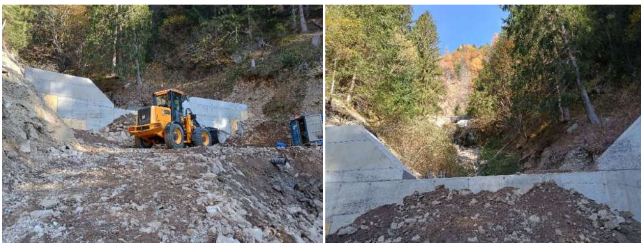
Fig. 1.25 – 1.26 - Opere in realizzazione (novembre 2025) nel tratto d'alveo compreso tra 930 e 970 m slm (foto Grisotto S.)
